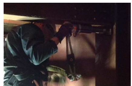
Het klinkgereedschap is compact genoeg om in de beperkte ruimte te gebruiken.
